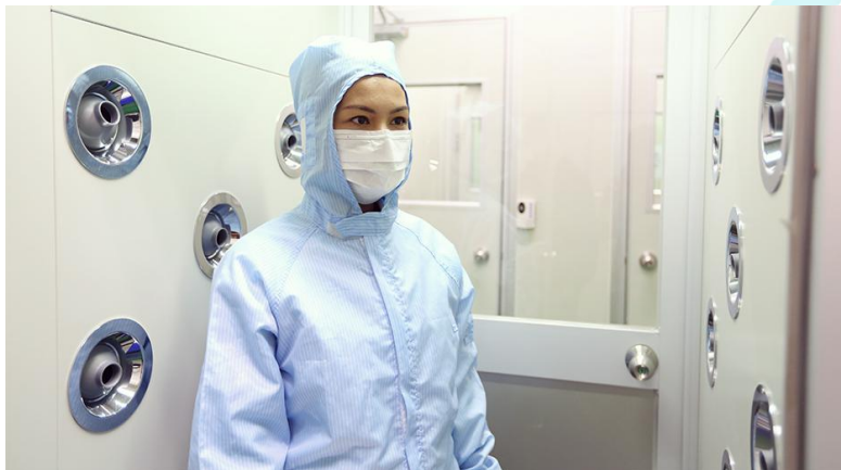
شکل ۵: دوش هوا مورد استفاده در ورودی اتاق تمیز
